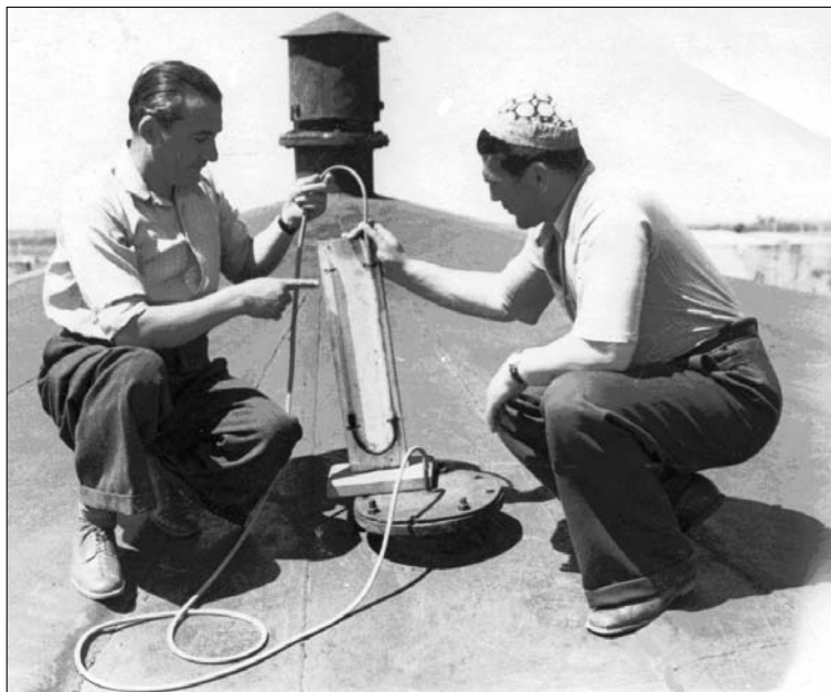
На крыше резервуара. А.С. Арзунян — слева. Вероятно, Херсонская нефтебаза, начало 50-х гг.
